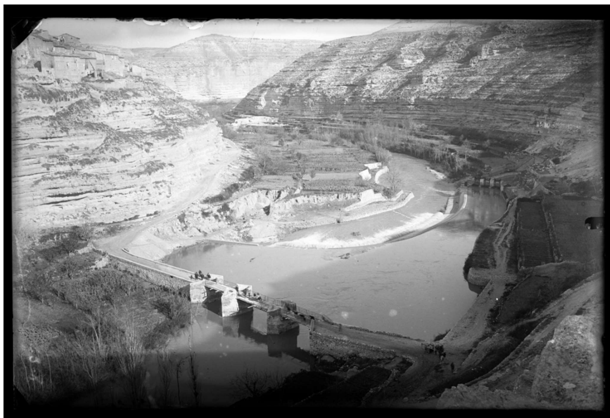
Nº IDENTIFICACIÓN: 01400-000023-008 – Puente y presa sobre el río Júcar (Albacete)
